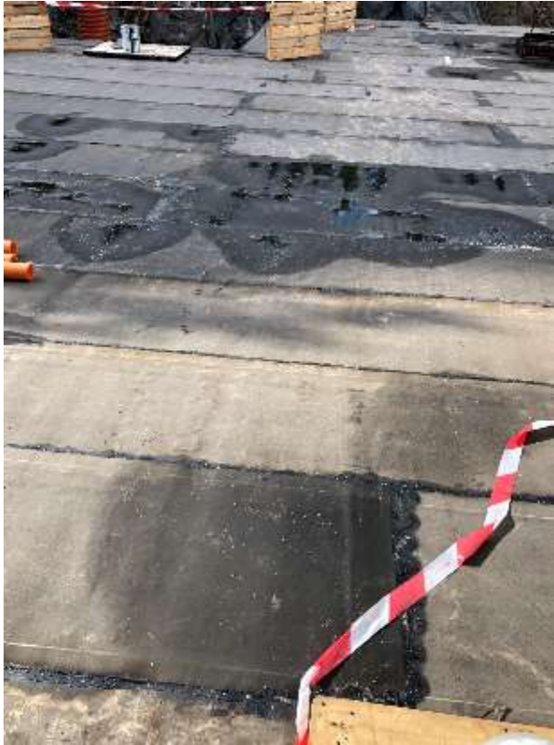
Cellplastkolor på en nybyggnation
