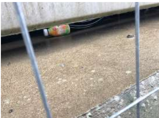
En flaska på väg ut från byggområdet. Alldeles nedanför är det vatten.
